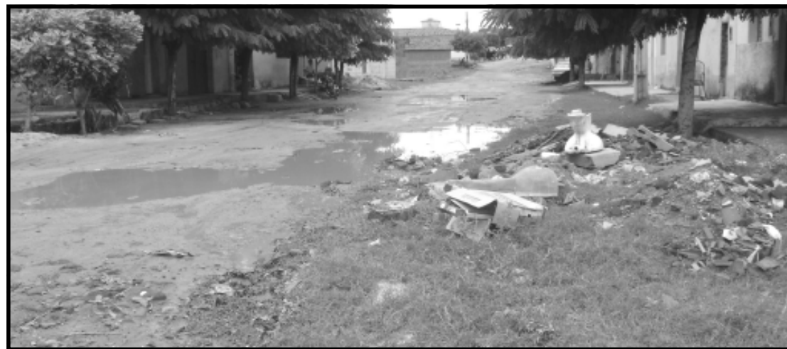
Trecho da Rua Unias Ramalho fotografado no começo do mês passado
